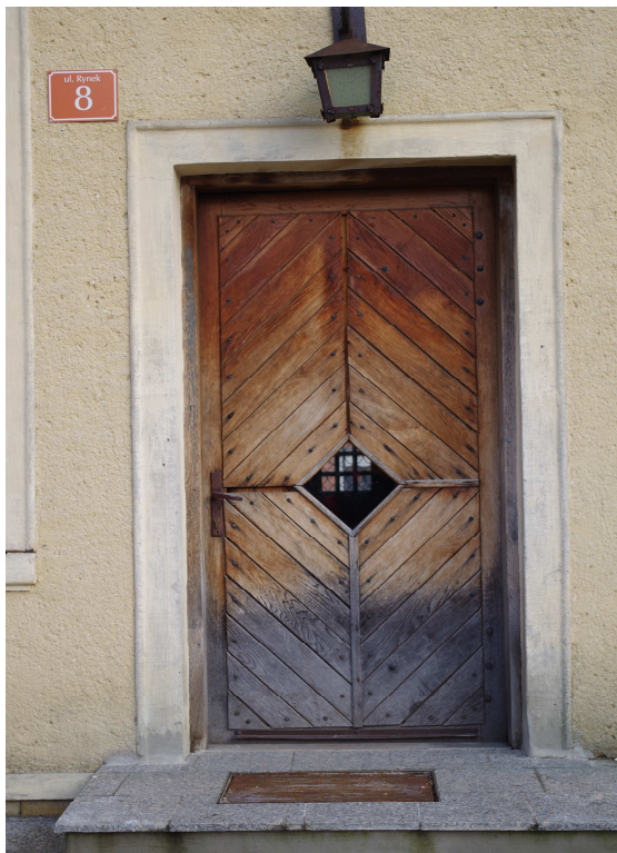
Fot Nr 3 Drzwi w elewacji zachodniej do wymiany i okładzina na spoczniku z płytkami lastryko do wymiany na płytki piaskowca .
