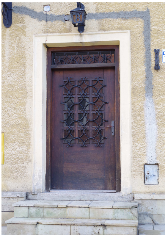
Fot Nr 4 Lampa do oświetlenia numeru , widok schodów i bruzda techniczna źle wykończona
